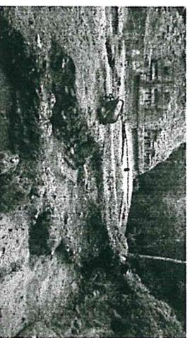
hiladas de sillares del muro de la fachada norte del edificio, aunque se encuentran en mal estado de conservación, todavía es posible definir los arranques para la restauración.
